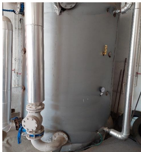
Слика 22. Део где скупља топлота у ОШ „8. септембар“ Пирот
