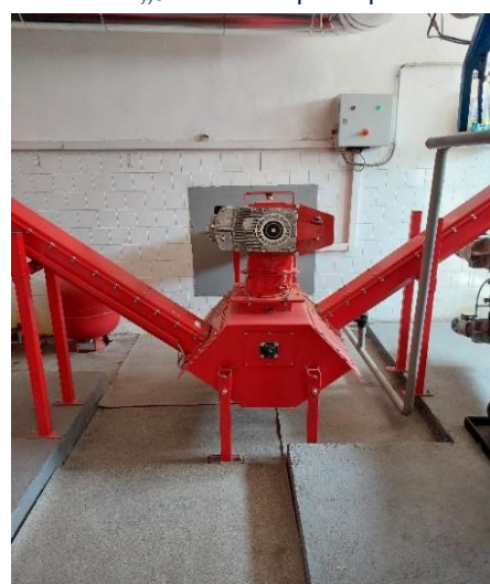
Слика 23. Део где се сипа биомаса у ОШ „8. септембар“ Пирот
